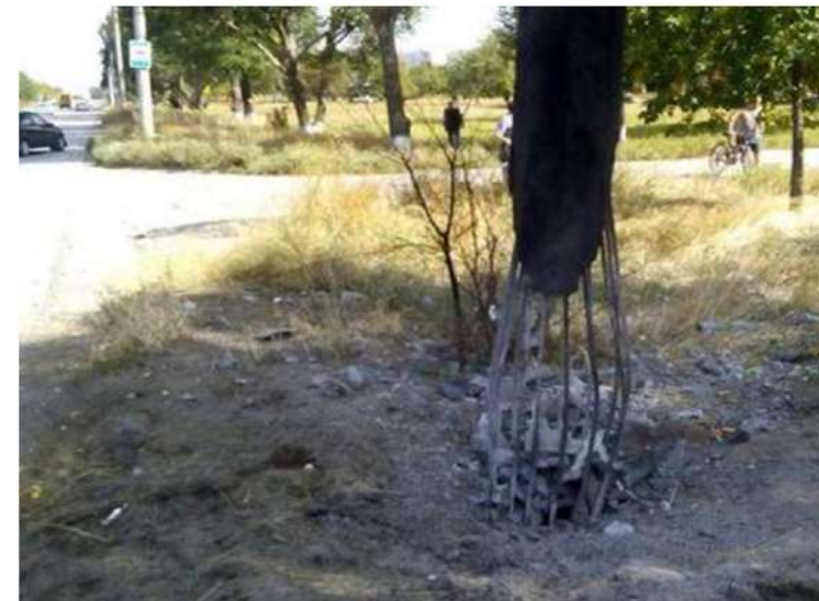
Наслідки спрацювання СВП, маскованих у дорожнє покриття та стовп
