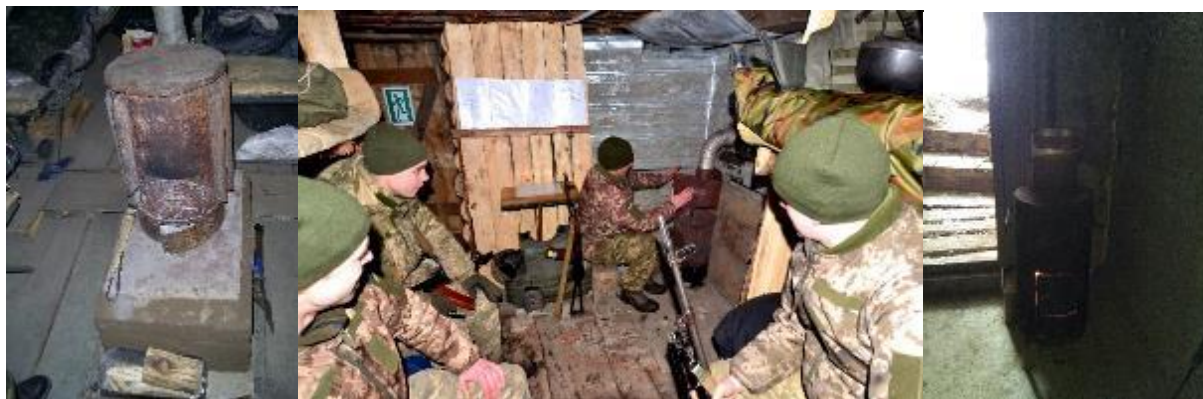
Рисунок 21 – розміщення металевої печі в бліндажі в районі ООС (раніше АТО).
