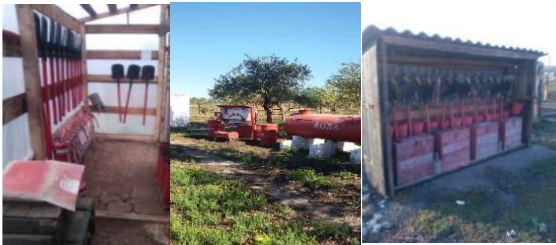
Рисунок 19 – обладнання місць зберігання первинних засобів пожежогасіння в районі ООС (раніше АТО).
