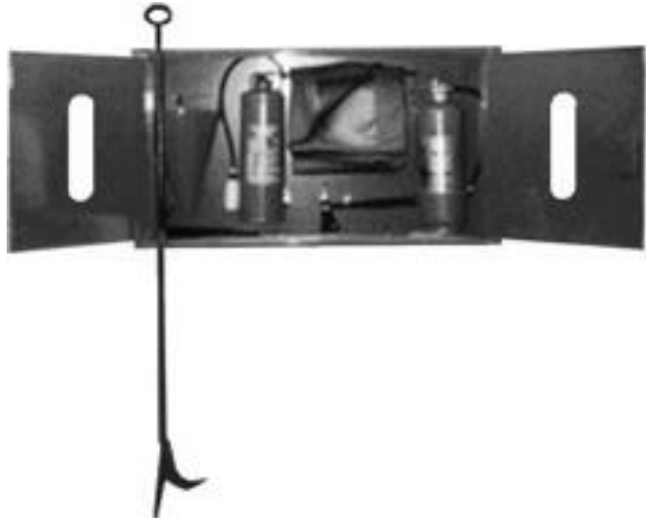
Рисунок 15.2 – Пожежний щит закритого типу
