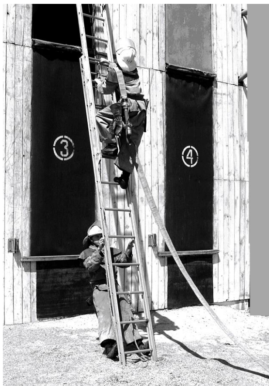
Рисунок 5.6 – Підйом рукавної лінії по висувній драбині
