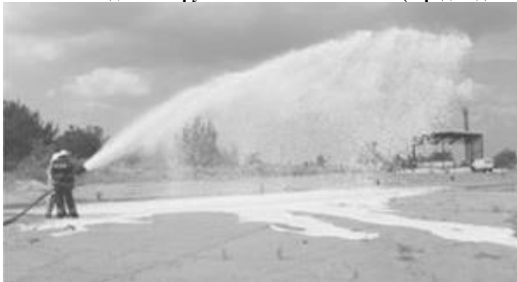
Рисунок 9.29 – Подання струменя ПМП з УГПС-600 (максимальна дальність)
