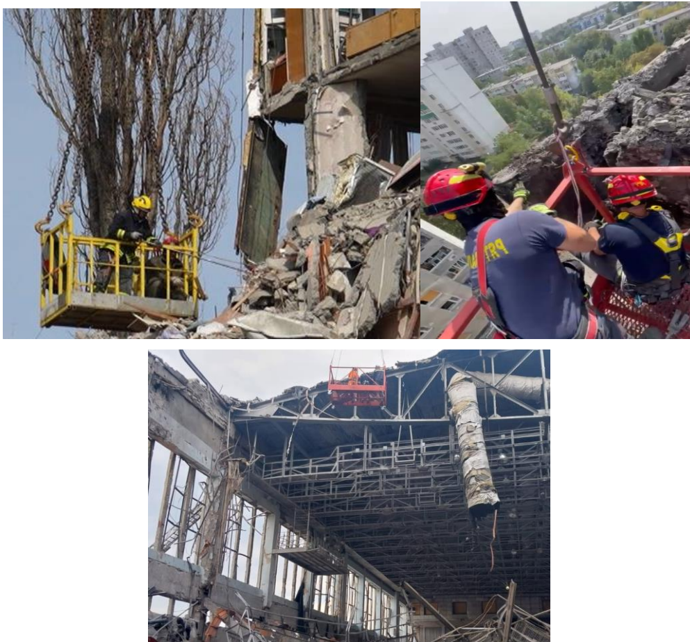
Рисунок 8.15. Висотні роботи з підвісної люльки, прикріпленої до автокранів
