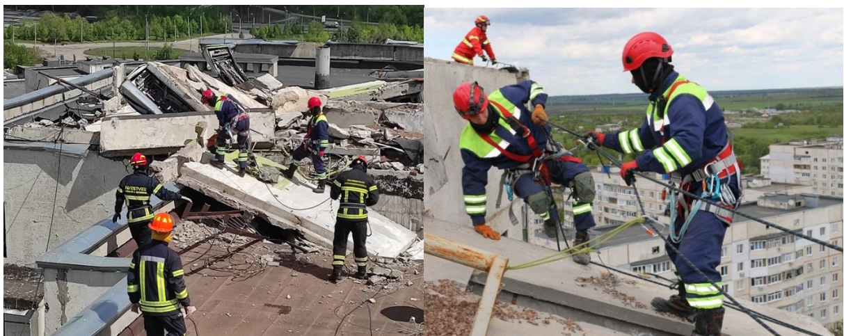
Рисунок 8.8. – Позиціювання в опорному просторі при проведенні висотних робіт.
