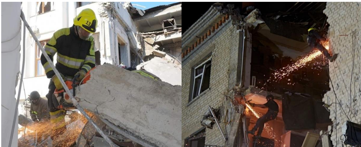
Рисунок 8.4. – Висотні роботи з розбору завалів та демонтажу нестійких будівельних конструкцій.
