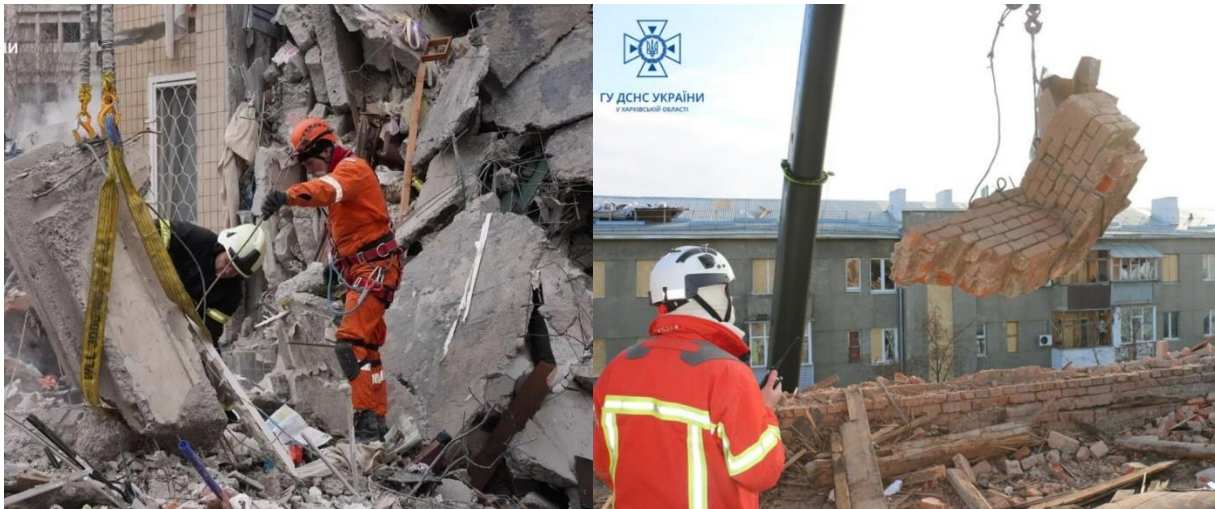
Рисунок 8.13. – Застосування текстильних та канатних стропів при демонтажу нестійких будівельних конструкцій
